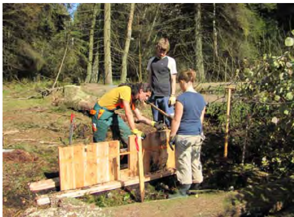
Abbildung 12: Sperrenbau im Arrisrieder Moos unter Anleitung von Dipl.Ing. (FH) Alexander Koch (HfWU) während des Praxis-Workshops in Bad Wurzach am 1.10.2011. (Foto: KoWU)
