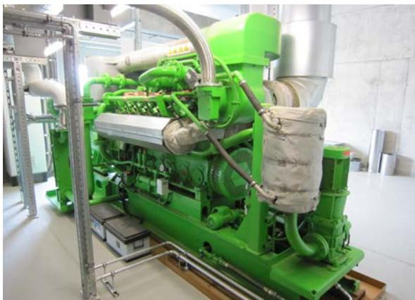
Biomethan-Blockheizkraftwerk in der Nahwärmezentrale
