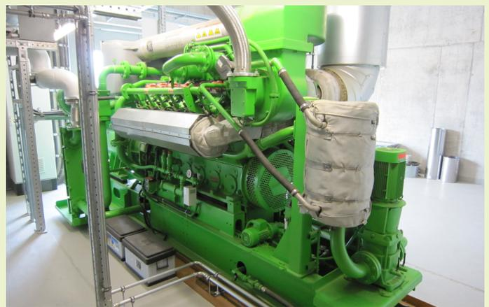
Abb. 2: Biomethan-Blockheizkraftwerk in der Nahwärmezentrale, Aldingen
