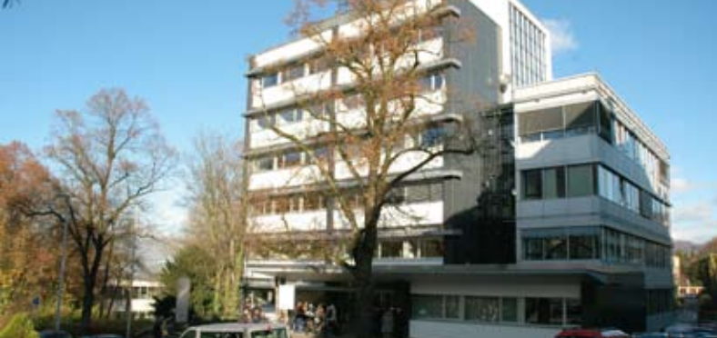
Das Gebäude in der Parkstraße 4 am Standort Geislingen nach der energetischen Fassadensanierung.
