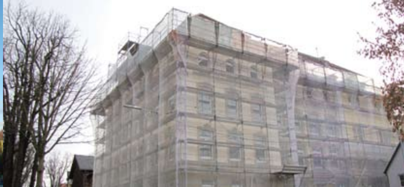
Sanierung der Außenfassade und des Dachbereichs des Kollegiengebäudes III im Altbauareal am Standort Nürtingen.
