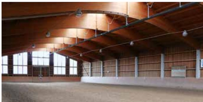
Die Reithalle (20 x 60 m) wird mit einer Stangenbewässerungsanlage bewässert.
