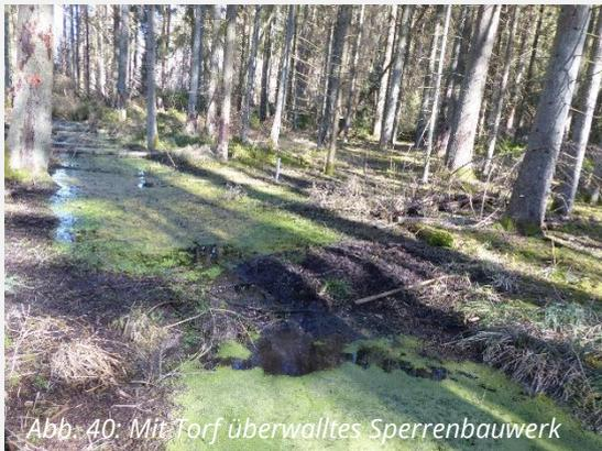
Abb. 40: Mit Torf überwalltes Sperrenbauwerk
