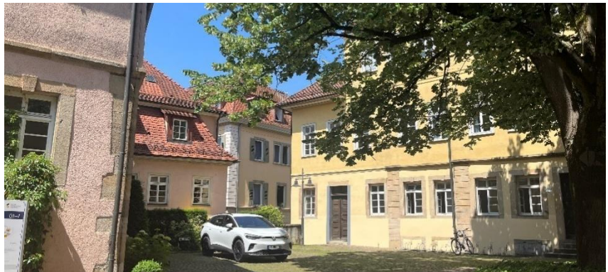
Abb. 1: Innenhof Campus Innenstadt CI1
